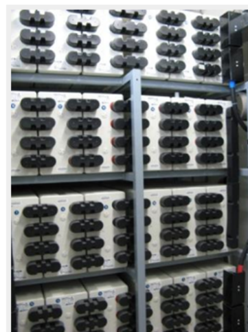
ダブル発電を蓄電する大型バッテリー。昨年9月から今年4月25日までの全体発電量比はコージェネ78%対太陽光22%だが、好天だった3月以降のみだと58%対42%。夏はさらに太陽光発電の数値が高まり60%以上にまでなるはずだという
